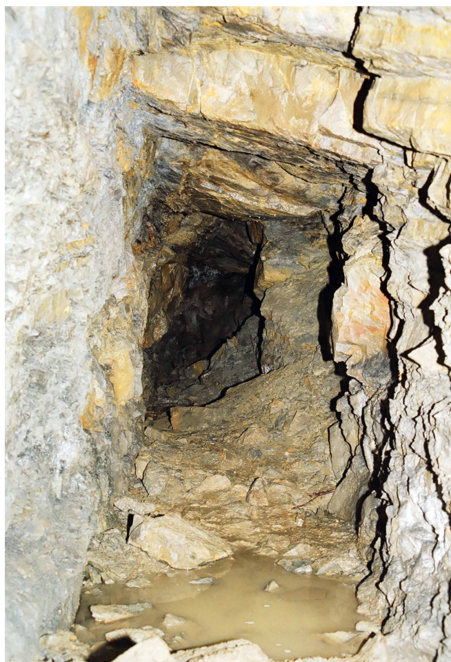
Fig. 16. Sztolnia w Potoku Pałkowskim, korytarz dolnego poziomu, fot. P. Gad • The Pałkowski stream adit, the lower level of the tunnel, phot. P. Gad
