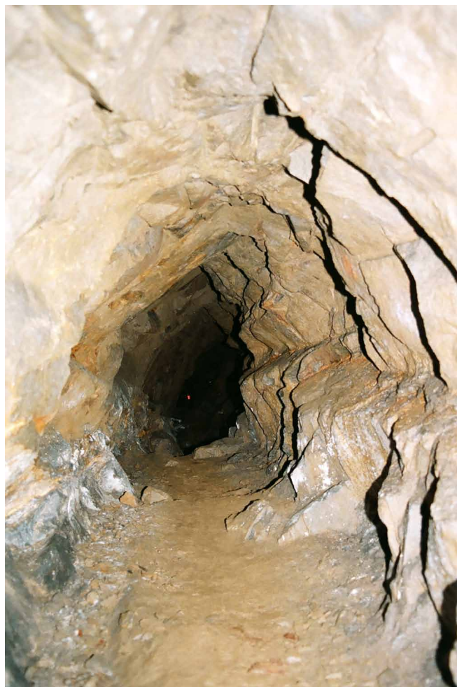
Fig. 13. Sztolnia w Jarmucie, korytarz górnego poziomu, fot. T. Kuś • The Jarmuta adit, the upper level of the tunnel, phot. T. Kuś
