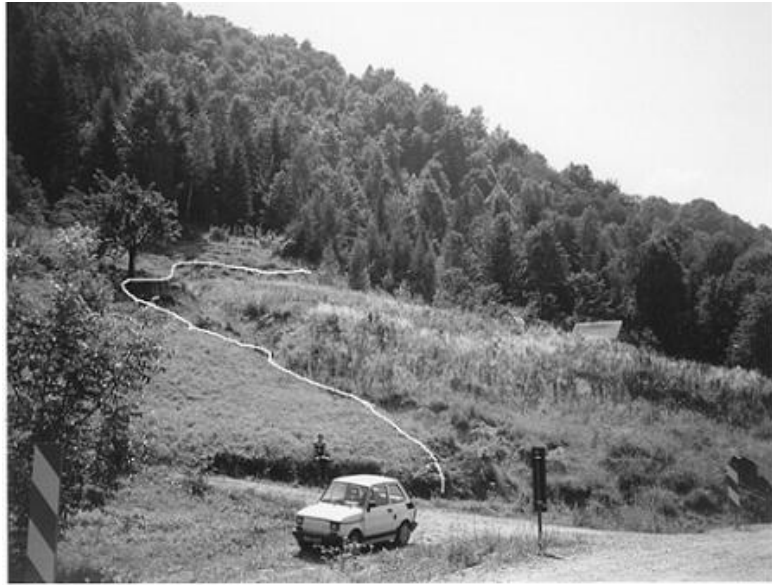
Rys. 4. Osuwisko Lipie - widok ogólny niszy osuwiskowej [fot. L. Zabuski].
