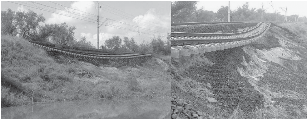
Fot. 2. Osuwisko w obrębie nasypu kolejowego (fot. GeoPartner)
