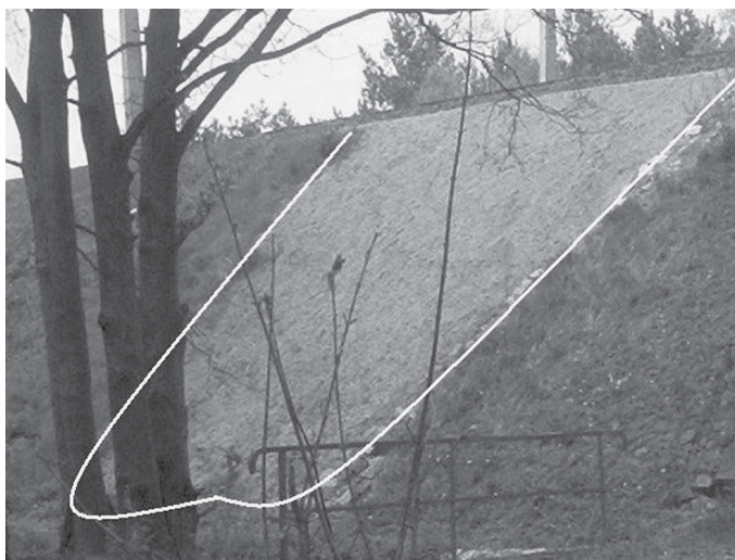
Fot. 1. Nasyp kolejowy z uzupełnieniem materiału w obrębie powierzchniowego zsuwu ośrodka (Fot. GeoPartner)
