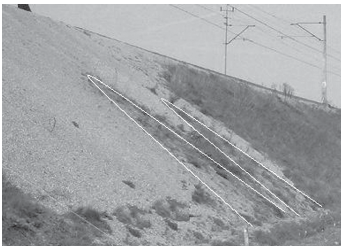
Fot. 3. Zrekonstruowany nasyp. Białą linią zaznaczono zasięg podciągania wody gruntowej (fot. GeoPartner)
