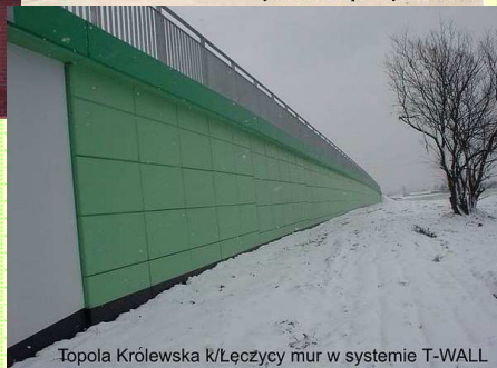
Topola Królewska k/Lęczycy mur w systemie T-WALL
