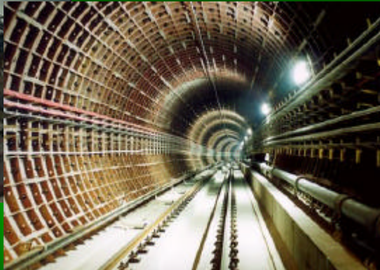
Obudowa tuneli z tubingów zeliwnych
