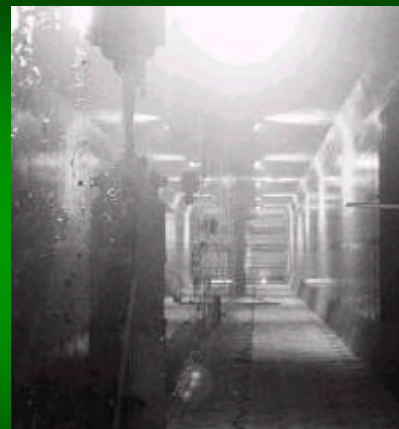
Segment tunelu pod woda
