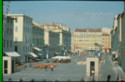
Po budowie parkingu
