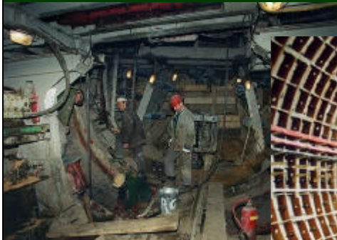
Przodek tunelu metra
