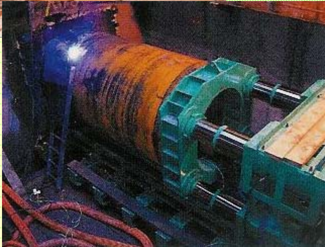
spawanie i przesuw rur stalowych
