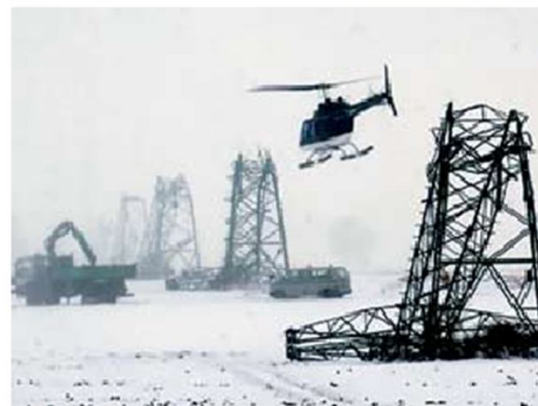
Skutki burzy śnieżnej w Niemczech, 24-25 listopada 2005 – linie E.ON-u
