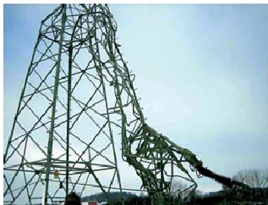
Skutki burzy śnieżnej w Niemczech, 24-25 listopada 2005 – linie E.ON-u
