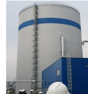
Zbiornik wodny w elektrociepłowni Vattenfall w Warszawie
