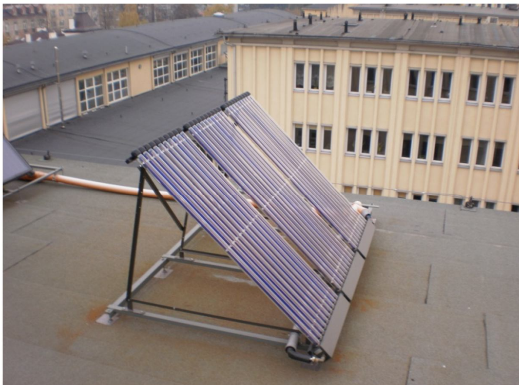
Próżniowe kolektory słoneczne Hewalex KSR 10 zamontowane na dachu budynku B3
