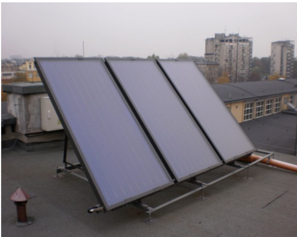
Płaskie kolektory słoneczne Hewalex KS 2000TLP zamontowane na dachu budynku B3
