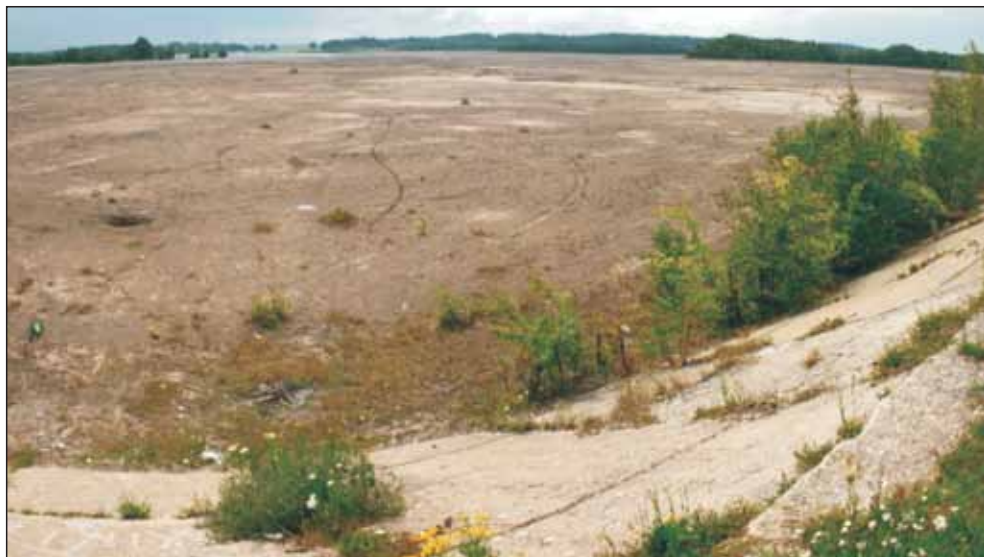
Fot. 31. Wartowice – zbiornik odpadów poflotacyjnych dawnej kopalni miedzi Konrad (fot. J. Pacuła)
