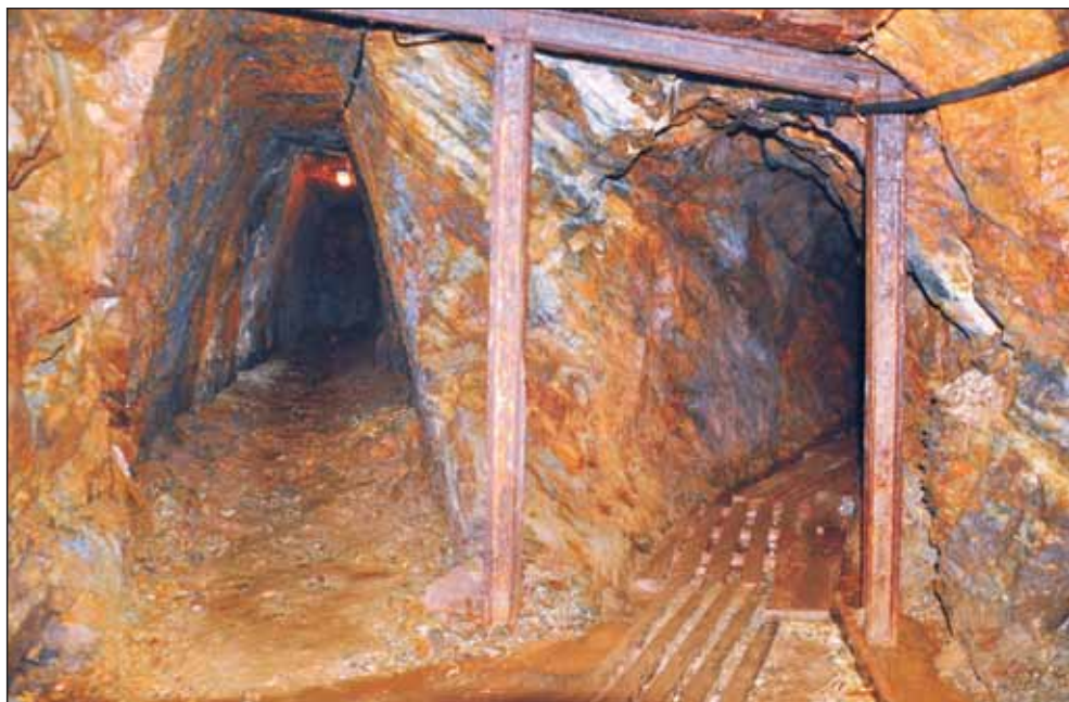
Fot. 37. Złotoryja, Kopalnia Aurelia – rozwidlenie podziemnych korytarzy w sztolni. Na ścianach skalnych zbudowanych z łupków zieleńcowych występują wykwitły wodorotlenków żelaza (fot. A. Ichnatowicz)
