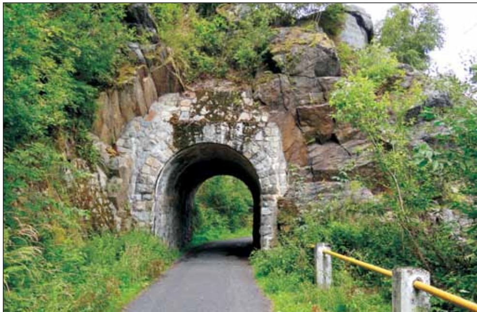
Fot. 5. Droga nad Jeziorem Złotnickim – tunel wykuty w ortognejsach izerskich (fot. J. Pacuła)
