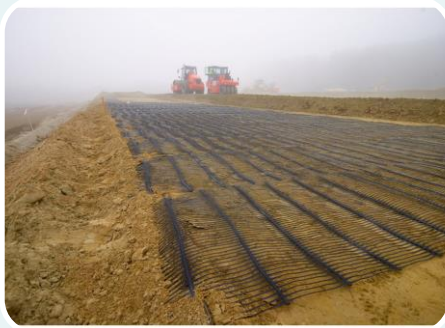
Zbrojenie skarp i zboczy
