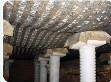
Zbrojenie podstawy nasypów opartych na palach wzmacniających słabe podłoże
