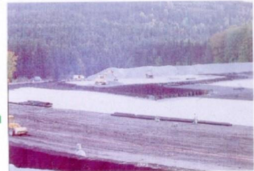
Składowiska odpadów przemysłowych
