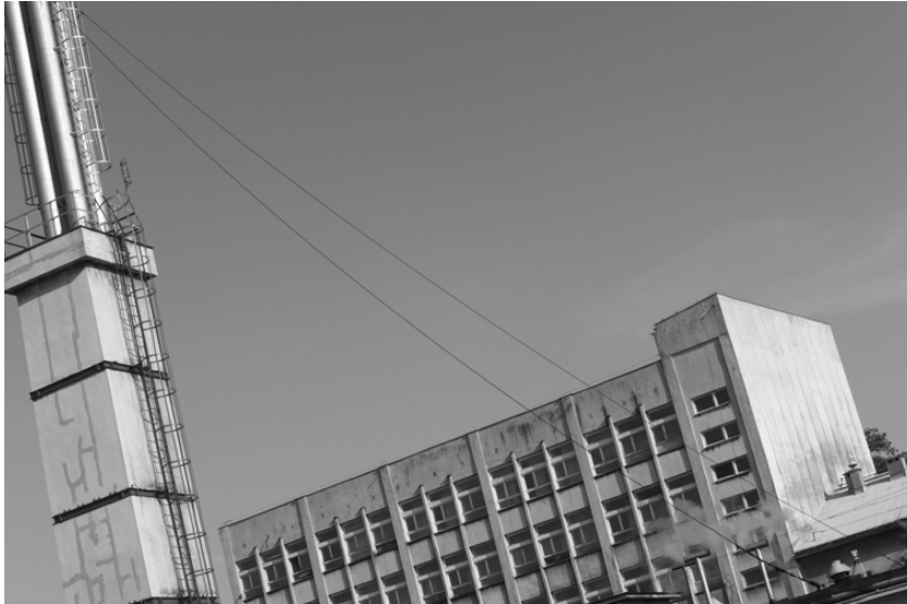
Rys. 5.18. Zarejestrowany kamerą cyfrową Kodak DCS 760 obraz linii wraz z punktami stanowiącymi podstawę przekształcenia rzutowego, którymi były: dwa punkty zaczepienia linii, trzeci – to sygnał na statywie, czwarty został zaznaczony na trzonie komina
