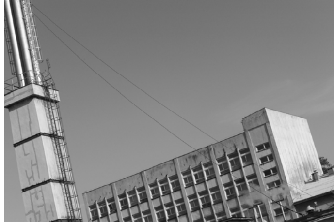
Rys. 7.18. Zarejestrowany kamerą cyfrową Kodak DCS 760 obraz liny wraz z punktami stanowiącymi podstawę przekształcenia rzutowego: dwa - to punkty zaczepienia liny, trzeci – to sygnał na statywie, czwarty został zaznaczony na trzonie komina
