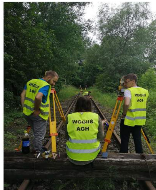
Pomiar geometrii toru suwnicy
