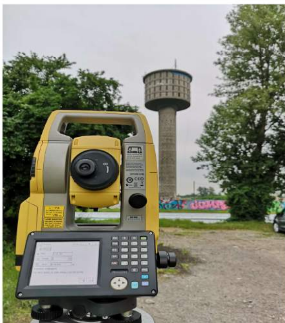
Pomiar kształtu osi budowli wieżowej
