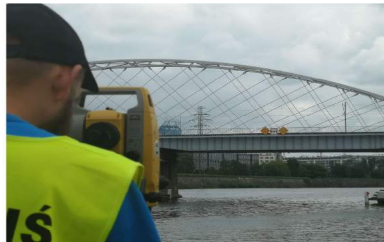
Pomiar ugięcia i wyboczenia przęsła mostu
