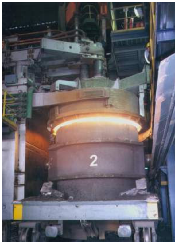
Rys. 12. Piec kadziowy (LF) w Hucie Zabrze.
