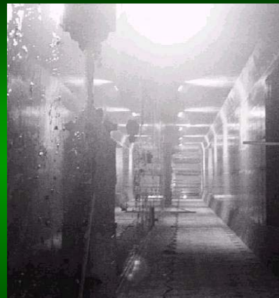
Segment tunelu pod wodą
