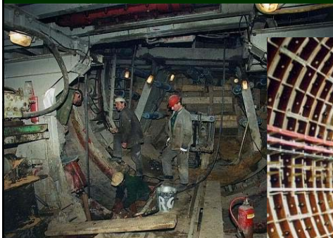
Przodek tunelu metra
