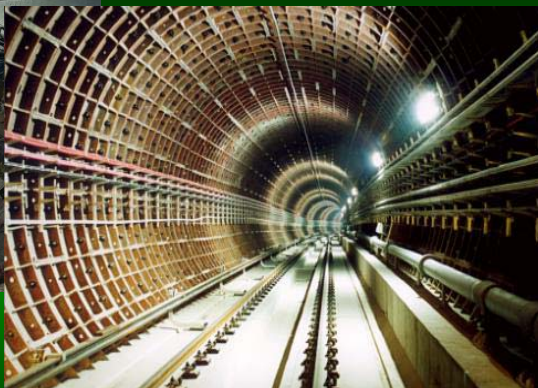
Obudowa tuneli z tubingów żeliwnych
