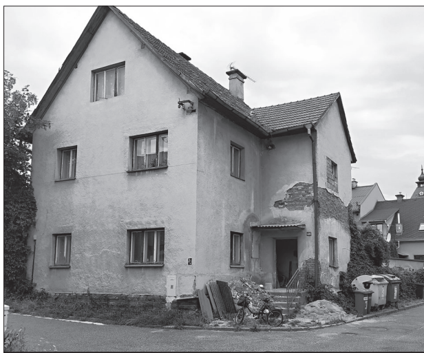
Současný pohled na budovu bývalé redakce spiritistického časopisu Posel záhrobní v Nové Pace (dnes ul. Čelakovského 495). Obě fotografie na této straně: J. Szymeczek.
