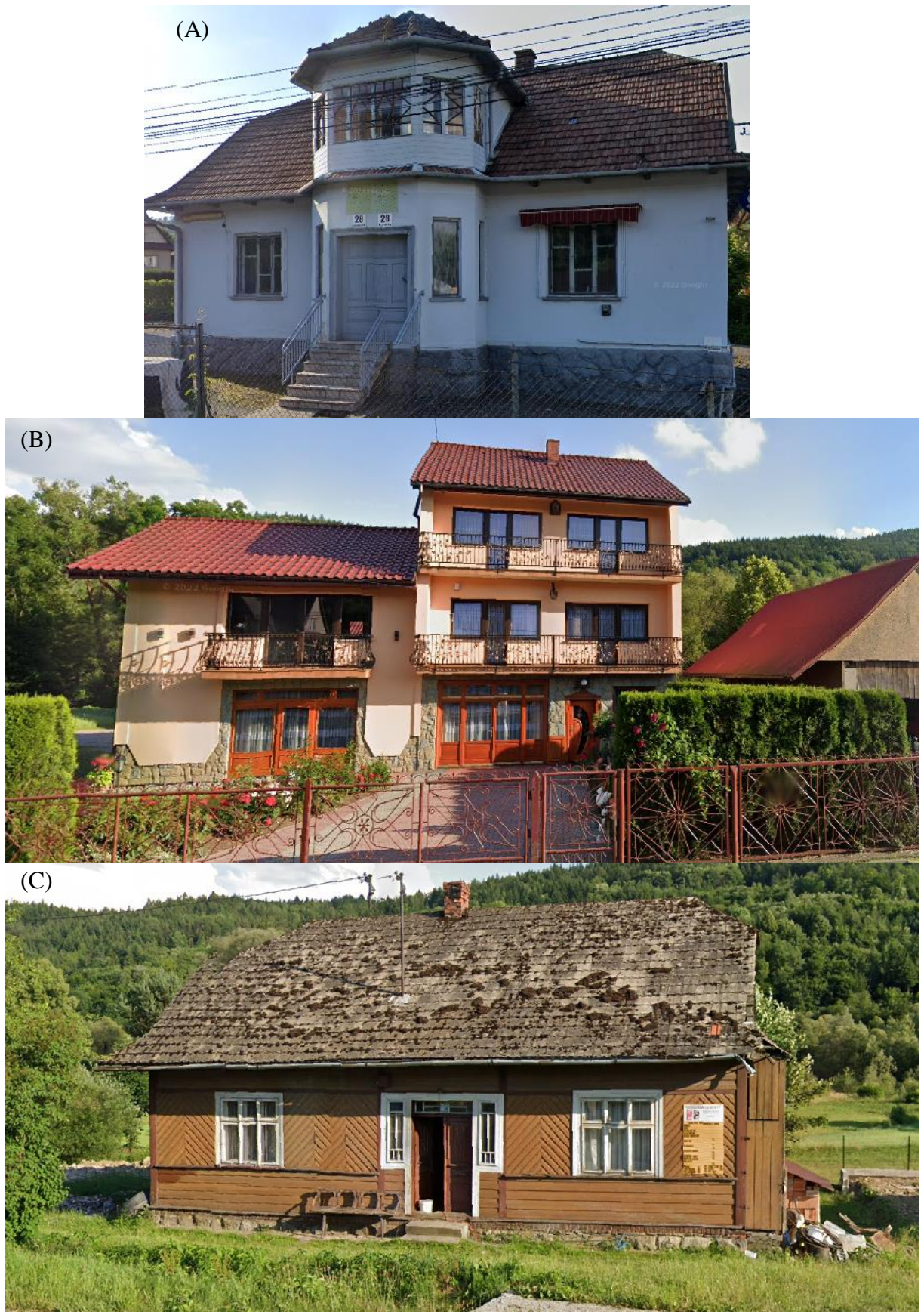
Rys. 7 Inne pokrycia dachowe we wsi Krzczonów: (A) dachówka cementowa, (B) blachodachówka, (C) dachówka cementowa (Google Street View)
