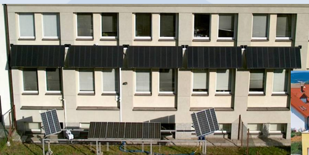
Fotowoltaiczny system zaciemniowy (markiza) AGH Budynek C-3
