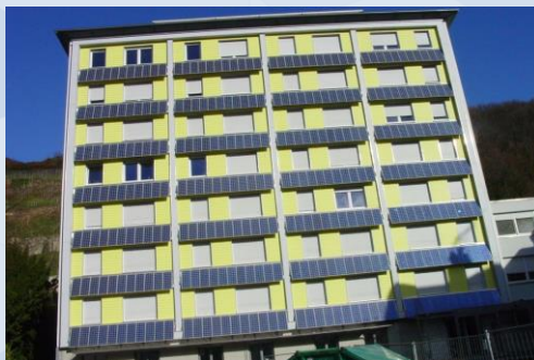
Elementy fasady budynku wykonane z baterii słonecznych
