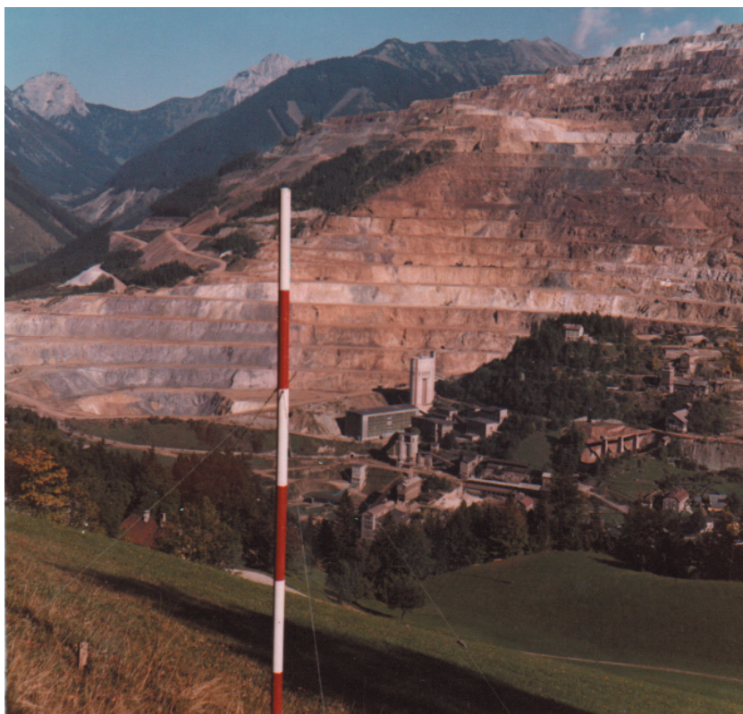
Rys. 1. Alpejska odkrywkowa kopalnia rudy żelaza Erzberg, długość frontów eksploatacyjnych wynosiła kilka kilometrów, rozpiętość odkrywki w pionie przekraczała 500 metrów
