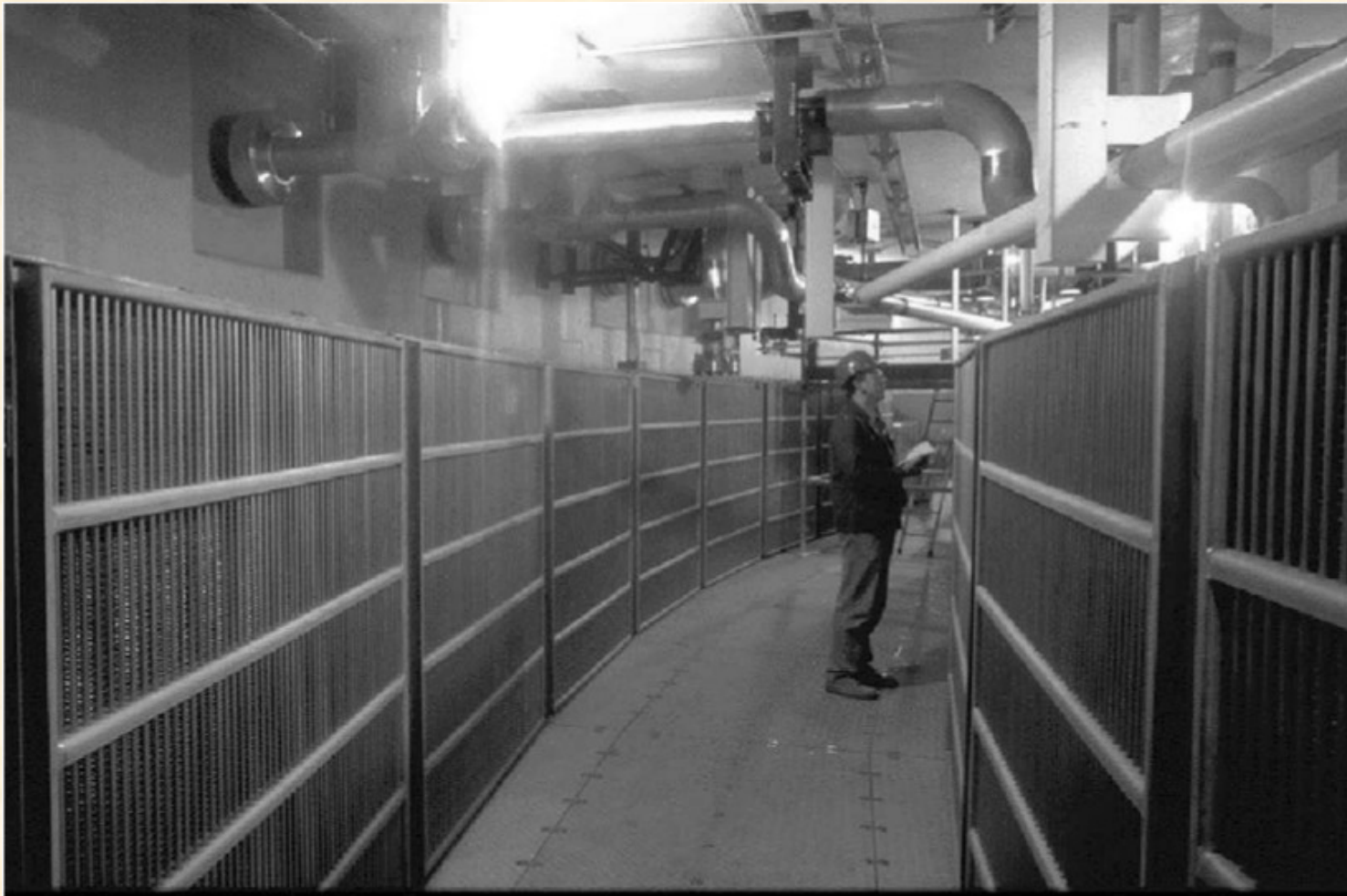
Chwyty wody (containment sumps)
