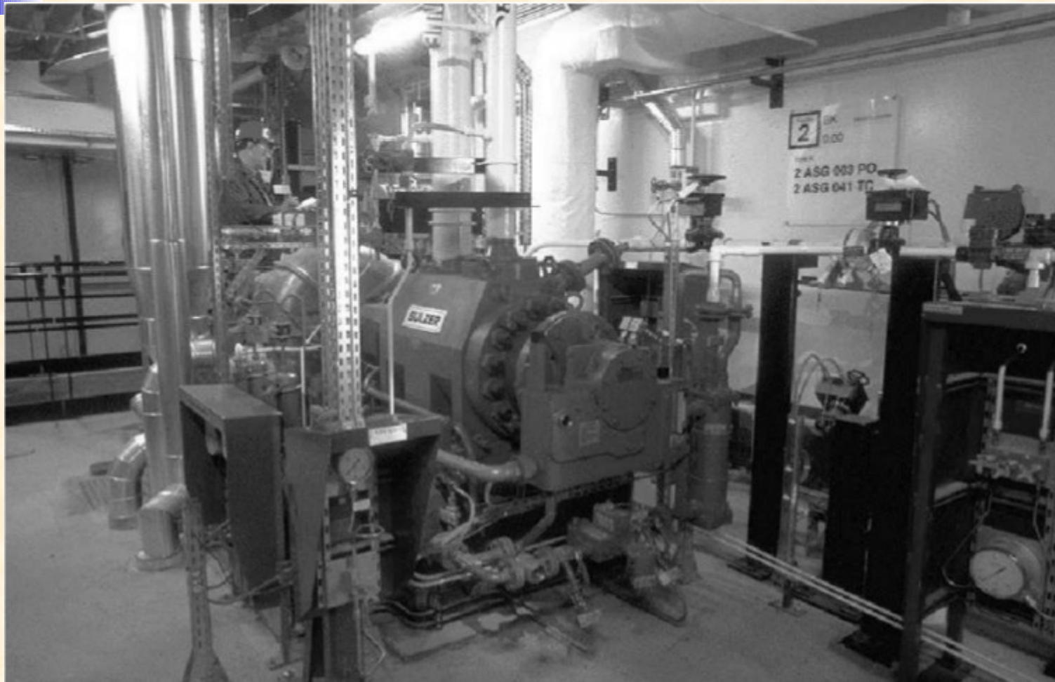
Napędzana parą pompa AFWS
