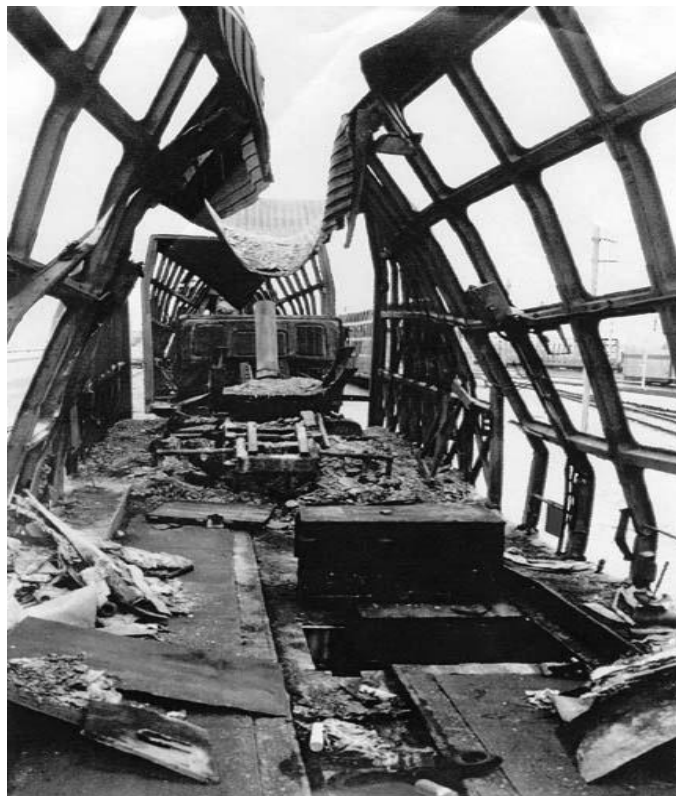
Rys. 0.6. Spalony wagon po pożarze w Eurotunelu [20]
