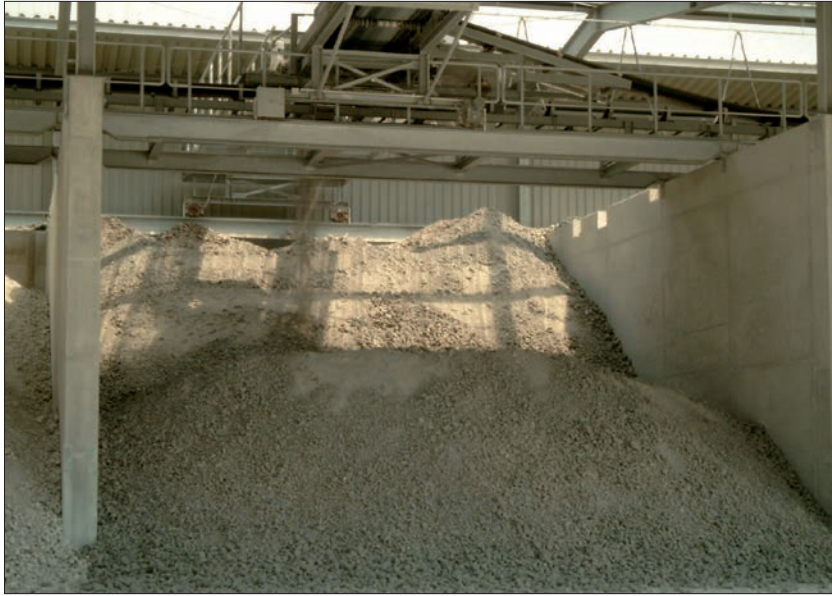
Fot. 7.13. Firma „Stephan Schmidt Meissen”. Zadaszone składowisko gotowej mieszanki surowca ilastego w zakładzie Kamenz (Saksonia, Niemcy). Stan z 2005 r.
