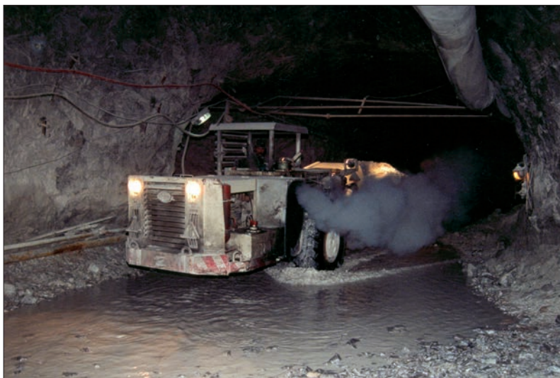
Fot. 11.2. Kopalnie Gipsu i Anhydrytu „Nowy Łądek”. Kopalnia podziemna anhydrytu Nowy Łądek w Niwnicach (Dolny Śląsk). Stan z 2006 r.
