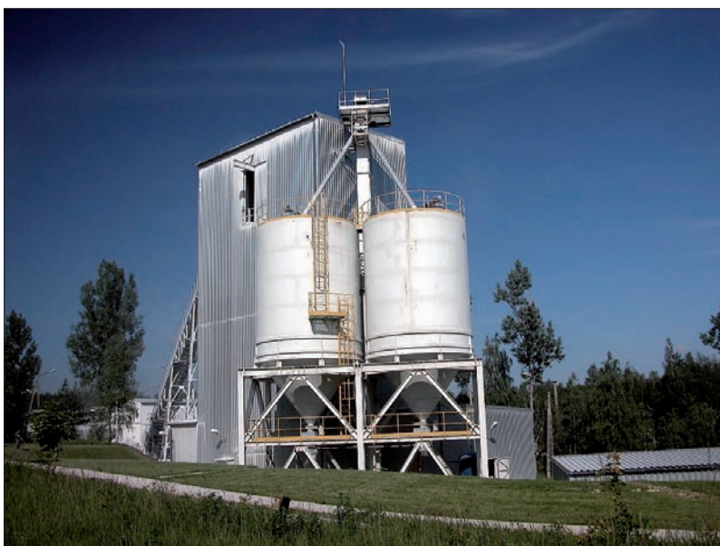
Fot. 11.4. Kopalnie Gipsu i Anhydrytu „Nowy Łąd”. Przemiałownia anhydrytu na terenie zakładu Nowy Łąd w Niwnicach (Dolny Śląsk). Stan z 2006 r.
