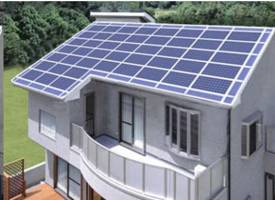
BIPV (zintegrowana z dachem)
