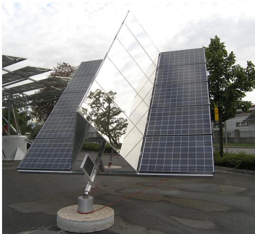
Układ koncentratorowy ok. 1,5:1 Moc całkowita ok. 3,5 kW
