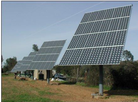
Konstrukcja umożliwiająca obrót baterii w obu osiach.
