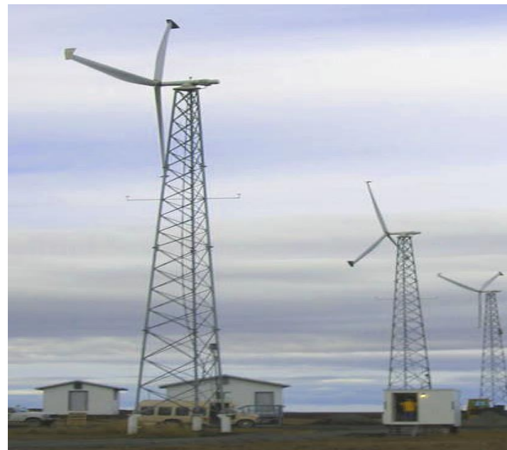
Rys. 42. Trójłopatowe siłownie typu "down-wind" o średnicy wirnika 15 m i mocy 50 kW firmy Atlantic Orient Company.
