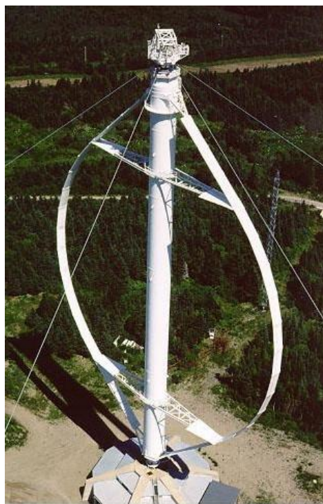
Elektrownia w Cap Chat w Kanadzie o wysokości 100 m i mocy 4 MW.
