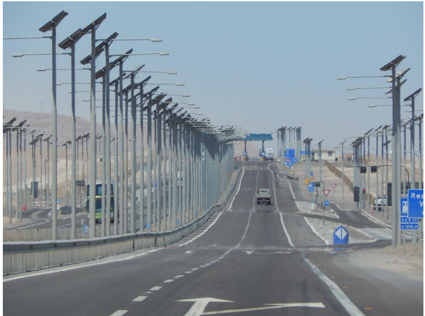
Oświetlenie węzła autostradowego Pustynia Atacama, Chile
