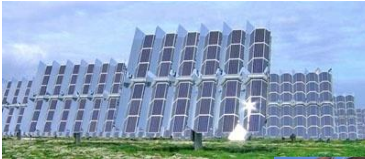
Sevilla PV PLANT (płaskie lustra)
