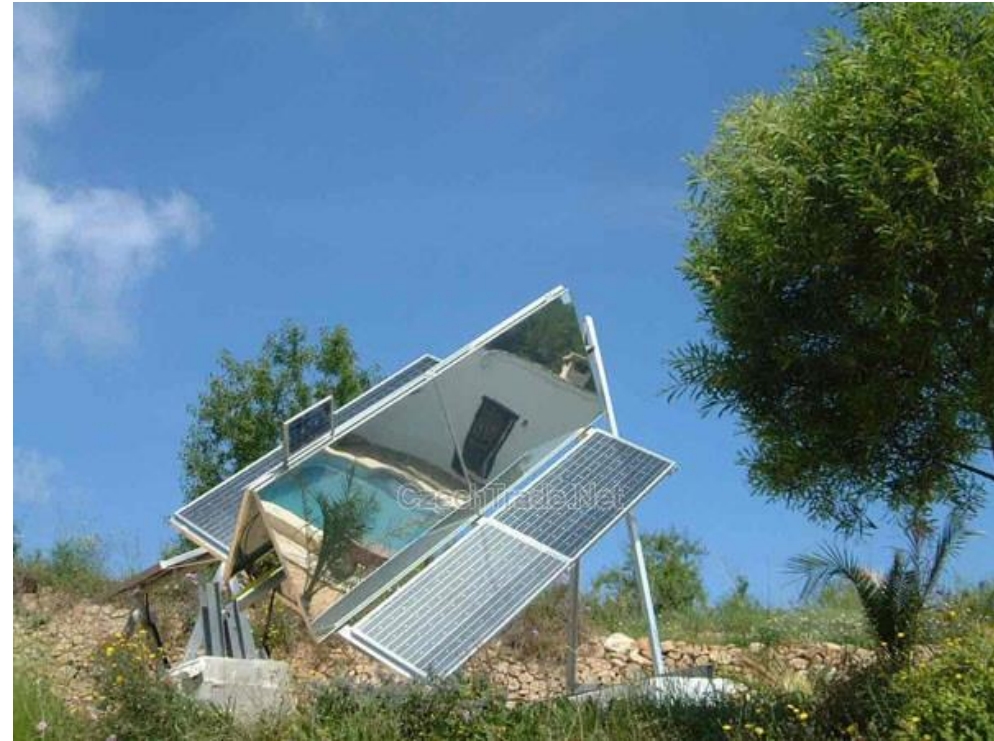
Układ koncentratorowy ok. 1,5:1 Moc całkowita ok. 1,5 kW
