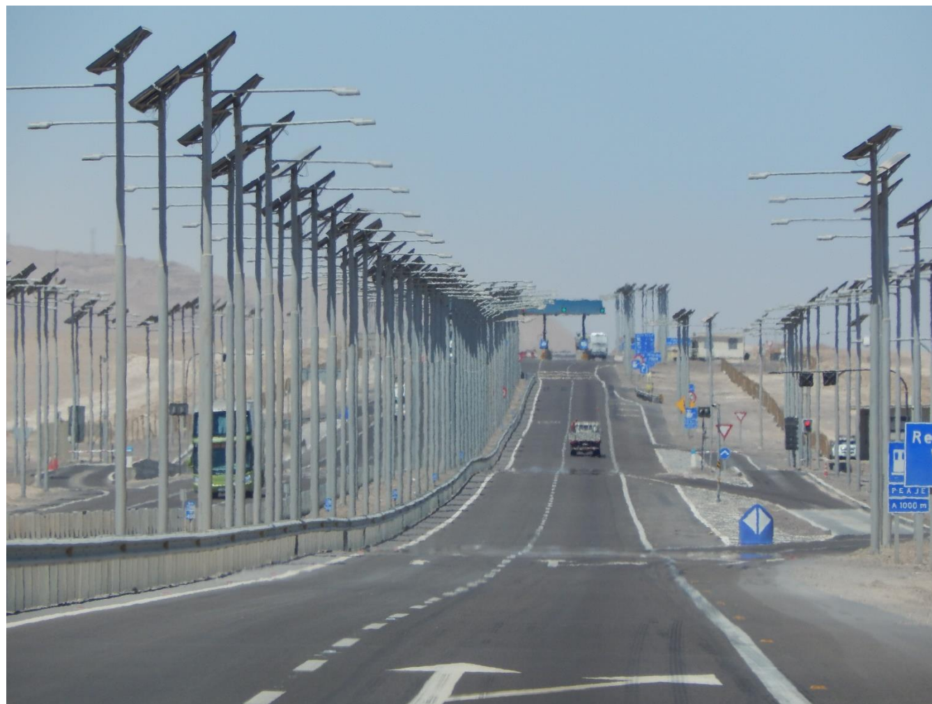
Oświetlenie węzła autostradowego Pustynia Atacama, Chile
