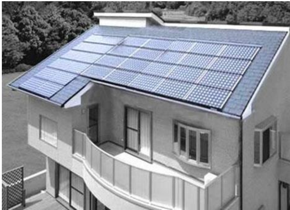
BAPV (doinstalowana do dachu)
