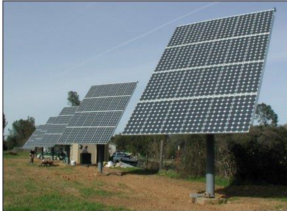
Konstrukcja umożliwiająca obrót baterii w obu osiach.
