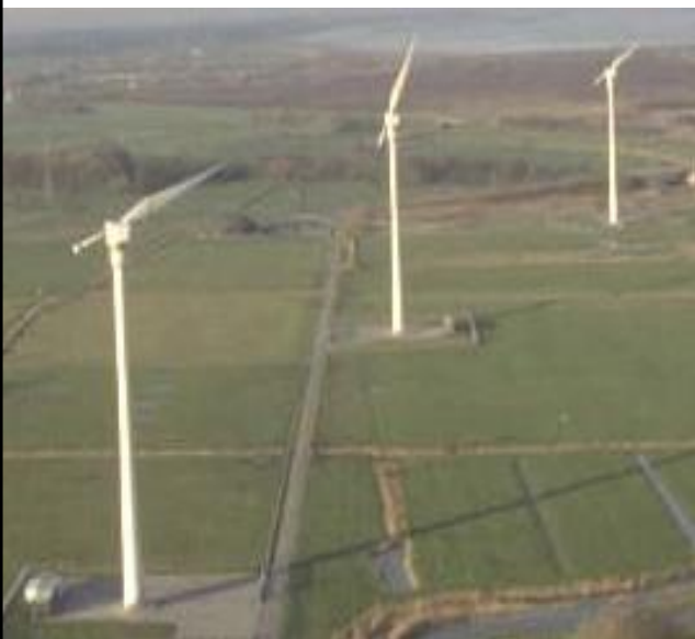
Rys. 38. Przykład trzech siłowni jednołopatowych o mocy 640 kW każda. (Wilhelmshafen, Niemcy)
