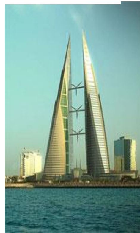
Rys. 47. Trzy turbiny o średnicy 30 m i mocy 225 kW w jednym z biurowców w Bahrajnie.
