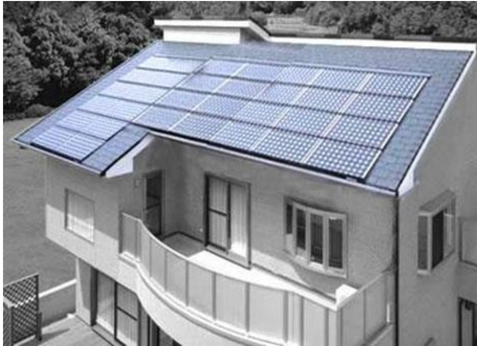
BAPV (doinstalowana do dachu)
