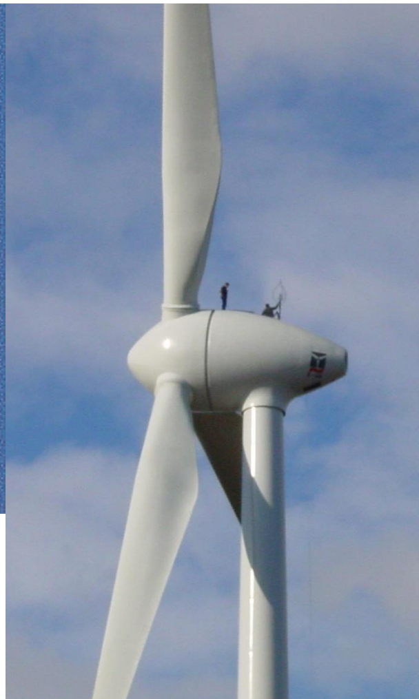
Rys. 29. Siłownia wiatrowa bez przekładni głównej i charakterystyczna sylwetka gondoli.
