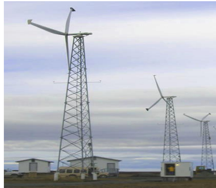
Rys. 42. Trójłopatowe siłownie typu "down-wind" o średnicy wirnika 15 m i mocy 50 kW firmy Atlantic Orient Company.
