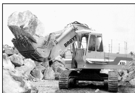
Rys. 9. Przenoszenie dużych brył skalnych łyżką ładowarkową
