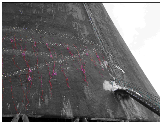
Rys. 6. Sieć strzałowa (nieelektryczna) w płaszczu chłodni
