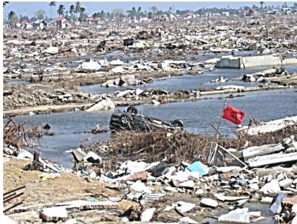
Rys. 157. Zniszczenia po tsunami
