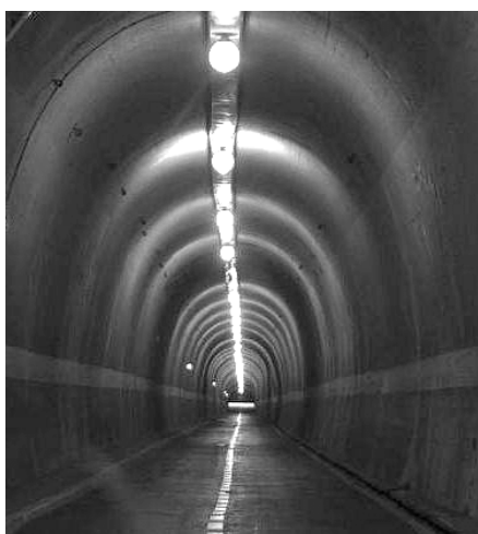
Zejsście do hali elektrowni na głębokość 50 m poniżej poziomu dolnego zbiornika
