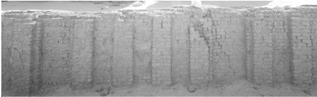
Rys. 6. Fragment muru z pilastrami
